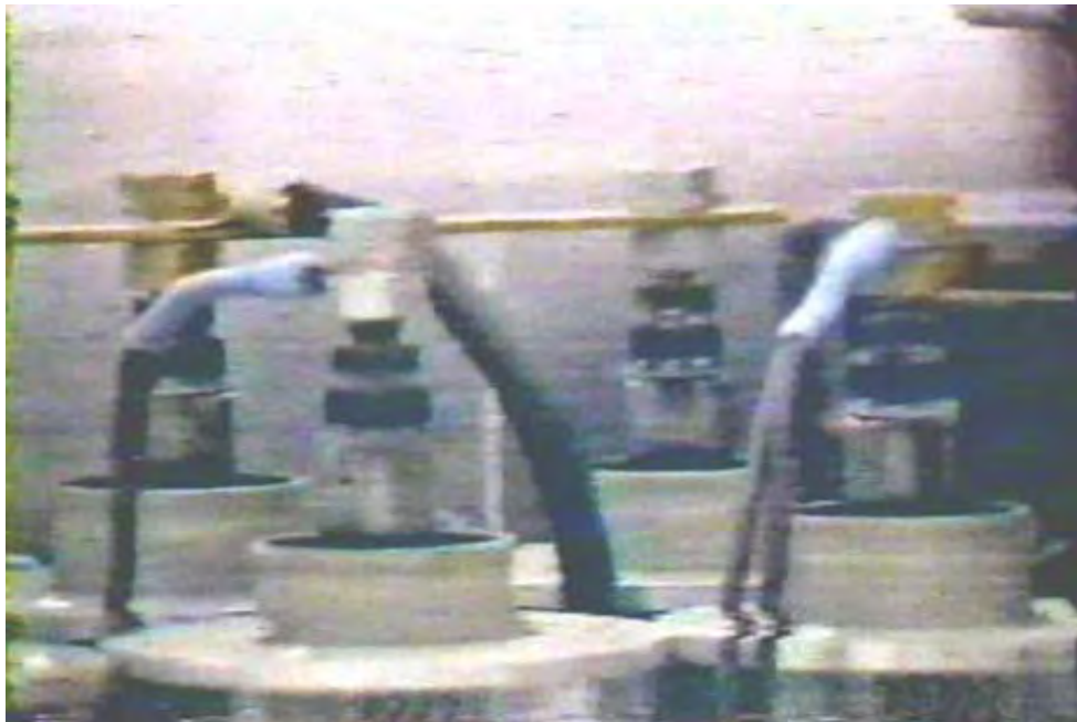
Ignitrons installés sur le " Rouge Motor Charrier "
