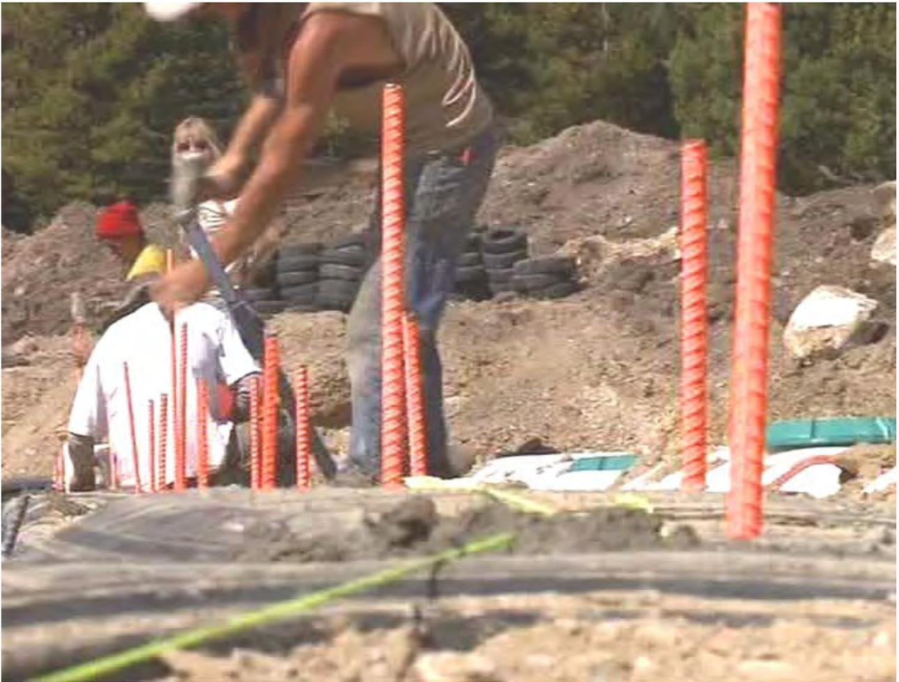
Le barre d'acciaio denominate "tondo per cemento armato" vengono inserite nelle pareti e posizionate all'altezza esatta, e un anello in cemento armato viene gettato intorno alla parte superiore delle pareti per dare forza complessiva alla struttura, prima che i tronchi degli alberi pesanti vengano messi in posizione.
