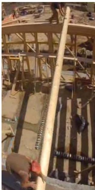
Queste travi sono molto pesanti e sono in grado di causare gravi lesioni se non gestite con cura e sensibilità. Formano i travetti che sostengono il tetto e c'è una distanza di circa un piede tra loro, quindi molti di loro sono necessari. Sono fissati alla parte superiore del muro da barre di acciaio guidate attraverso di loro e sul muro.
