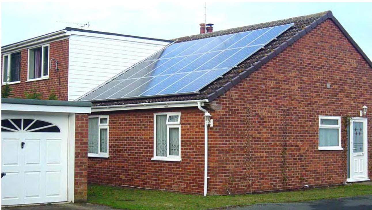
ha ventuno pannelli montati sul tetto e il costo totale per il proprietario di casa era solo £ 500. Il proprietario di casa riceve un costo di energia elettrica molto ridotto e prevede di recuperare il costo di installazione entro due anni. Anche nel mese di novembre alla latitudine 52 gradi nord, questi pannelli stanno ottenendo buoni risultati. Nessuna batteria sono coinvolti ed i pannelli legano direttamente alla rete elettrica.
