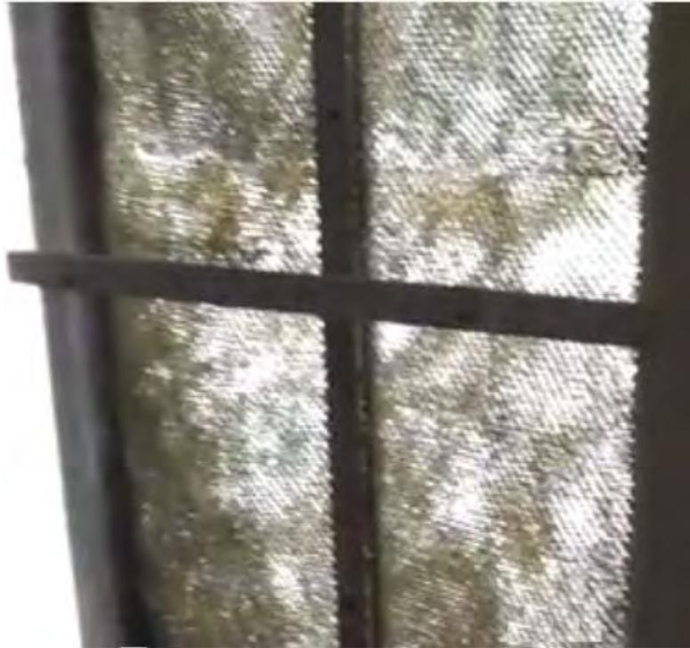
Le pastiglie sono mantenute bagnate da gocce d'acqua pompata alla parte superiore della finestra di una piccola pompa sommersibile sommerso in una scatola di immagazzinaggio di plastica grande riempita d'acqua:
