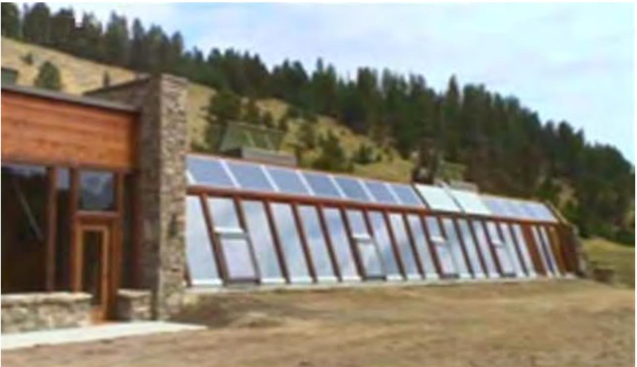
Le pareti della proprietà sono spesse sette piedi (2,13 metri) per consentire l'uso di materiali abbastanza semplici e, cosa più importante, per fornire una massa termica che mantiene l'interno dell'edificio caldo
