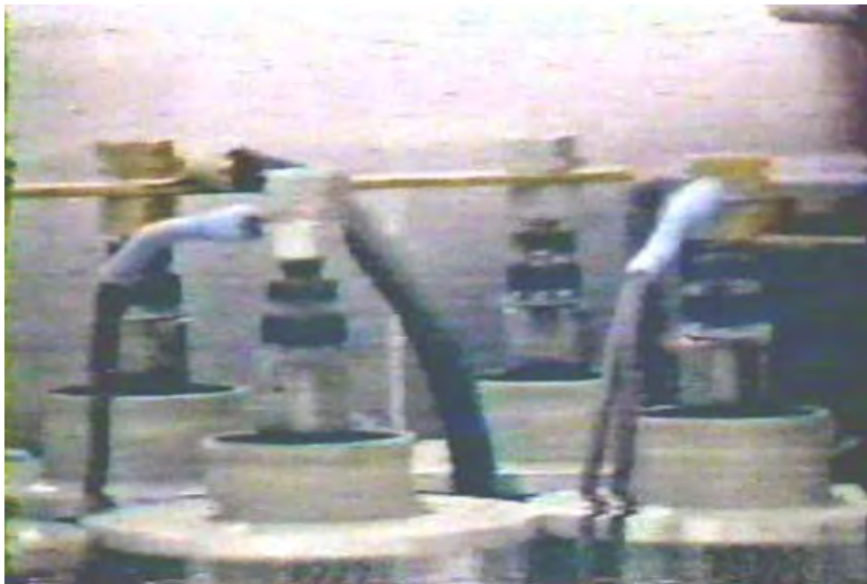
Ignitrons auf der "Red Motorwagen" installiert
