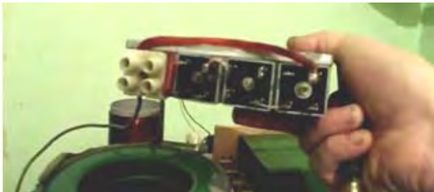
Tre ponti di diodi 1000V può essere collegato a sopportare una tensione di 6 kV.
